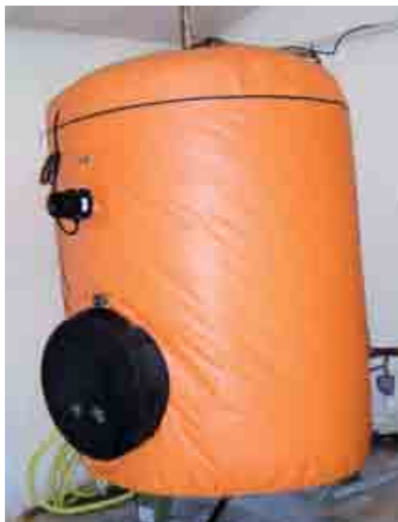
Photo 14 : la capacité des chauffe-eau électriques à accumulation doit être parfaitement dimensionnée pour éviter de fonctionner en heures pleines.
