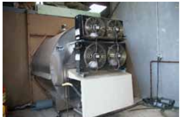
Laiterie « nouvelle génération » : avant du tank dans la laiterie ; arrière à l'extérieur (sous un auvent ou abri bien ventilé)
