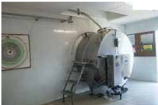
Laiterie « nouvelle génération » : avant du tank dans la laiterie ; arrière à l'extérieur (sous un auvent ou abri bien ventilé)
